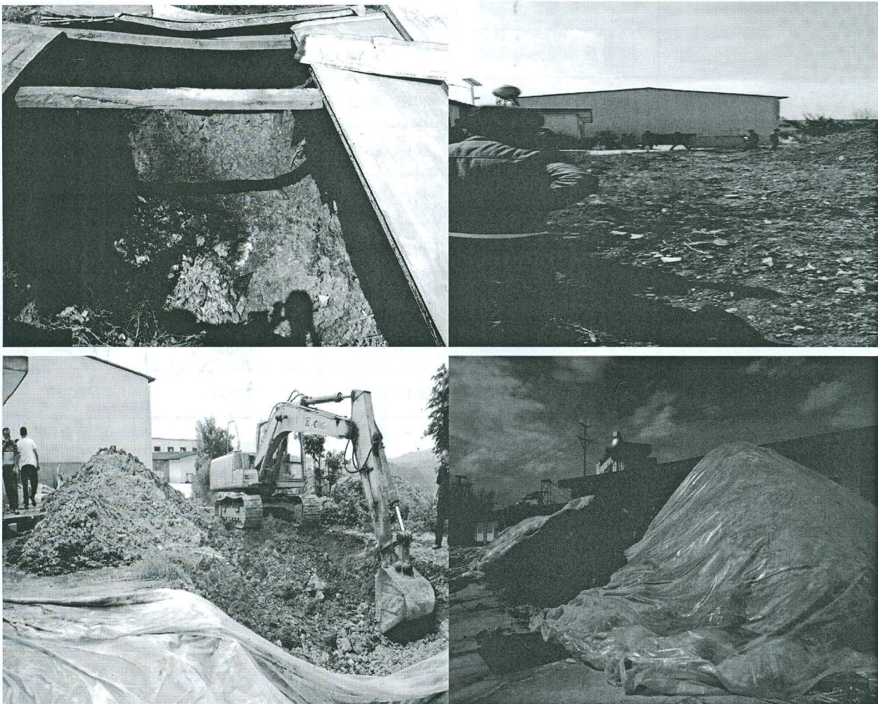
图 1-1 现场查看及现场挖油墨污染土壤
