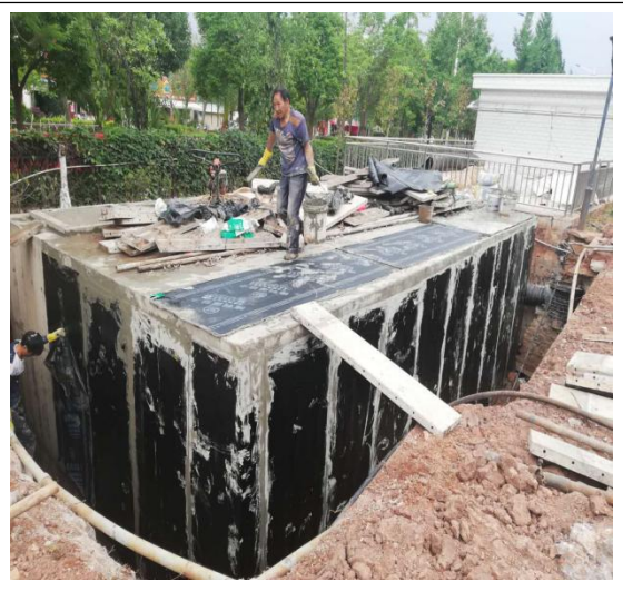
事故水池施工过程
