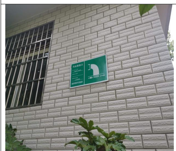
污水处理站总排口规范化标识牌
