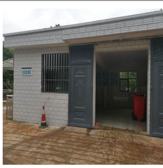
一般固废暂存间（生活垃圾房）
