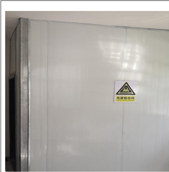
危险废物（废机油）暂存间
