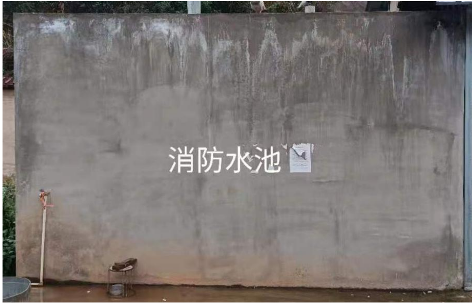
附图 3 消防水池
