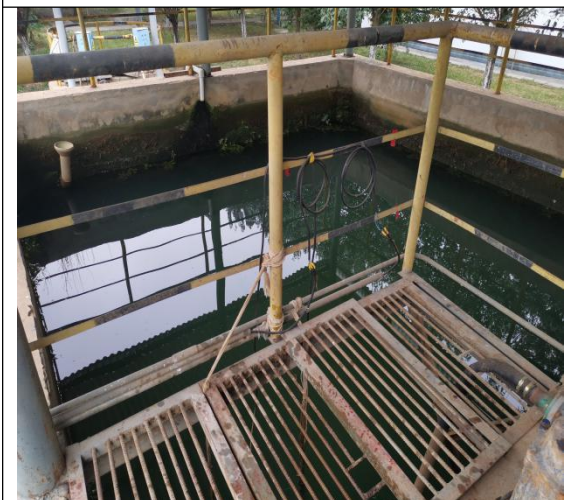
生活污水处理站回用水池
