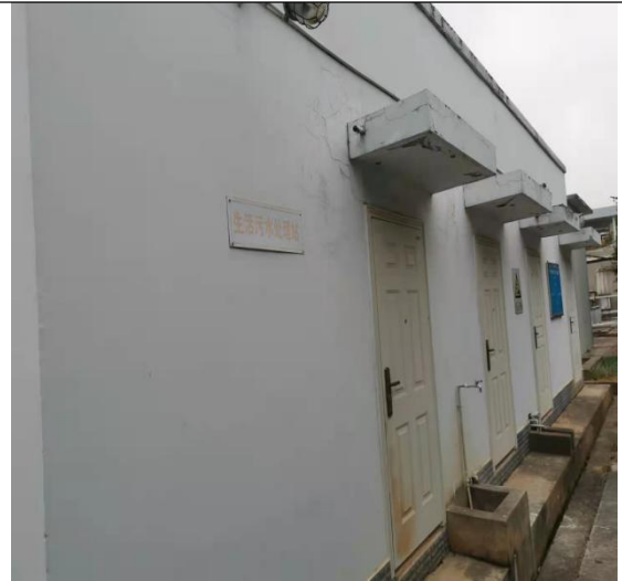
依托生活污水处理站
