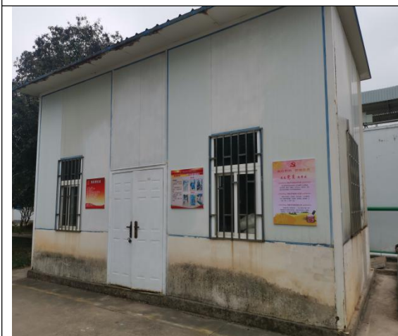
生产（酸碱）废水处理站化学药剂储存库
