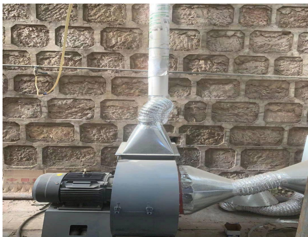
有机废气排气筒
