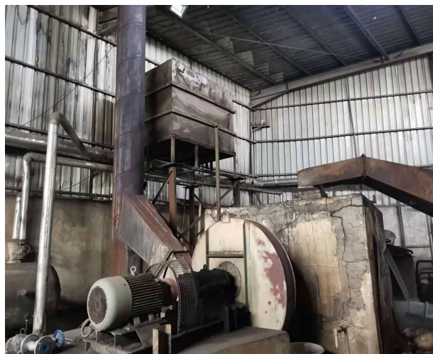
项目 6t/h 锅炉水膜除尘装置
