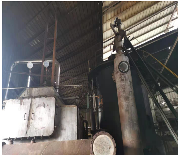
项目 6t/h 锅炉水膜除尘装置
