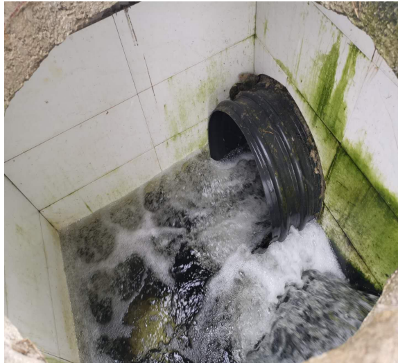
污水处理站出水口
