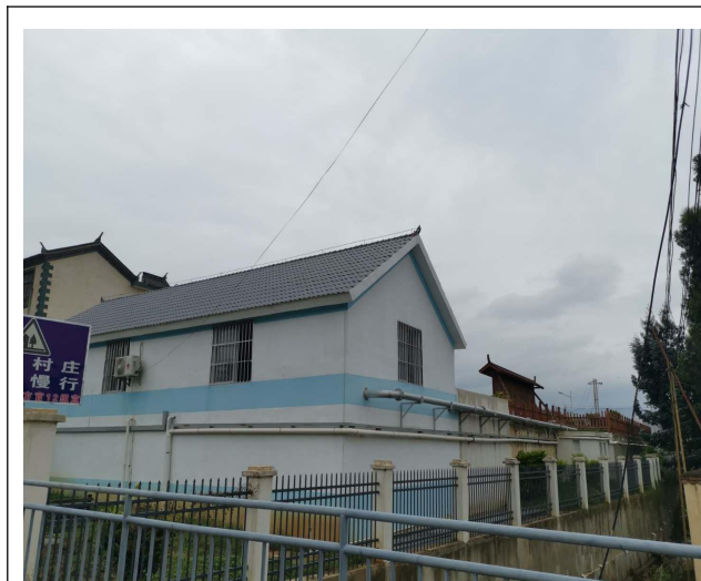
3000m 3 /d 污水处理站概貌
