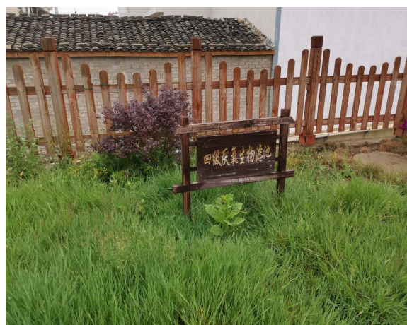
污水处理站→厌氧生物滤池（地埋式）
