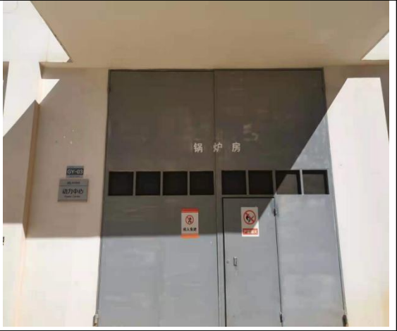
动力中心锅炉房
