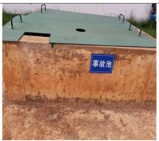
600m 3 事故池（加盖空置）
