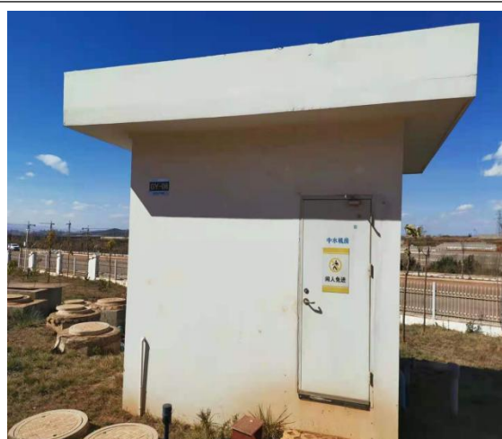
中水处理站设备间
