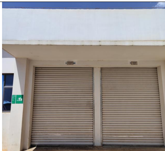
一般固废暂存间
