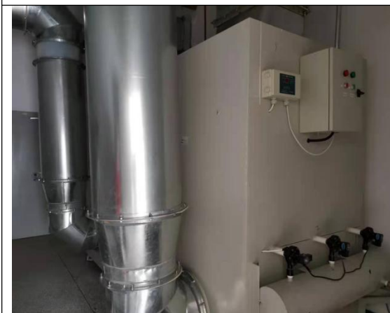
废气处理带式除尘器
