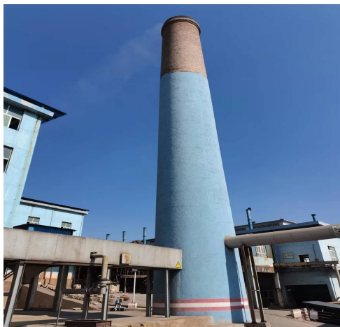
项目废气总排口烟囱
