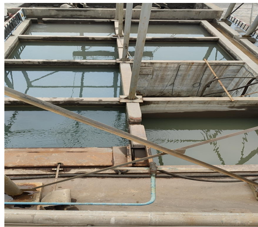
项目循环沉淀池
