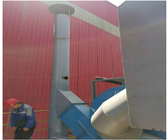
16#: 制成车间矿粉磨熟料散装机除尘系统
