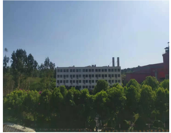
厂区办公生活区
