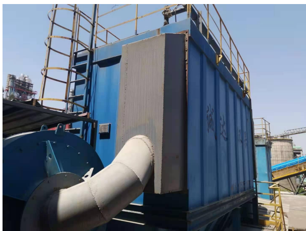
7#: 烧成一线斜拉链地坑除尘系统
