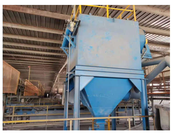
12#: 发运一线 2 号钢平台皮带除尘系统
