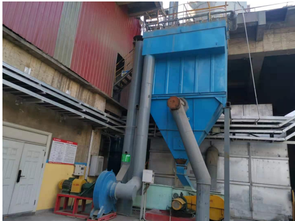
7#: 烧成一线斜拉链地坑除尘系统
