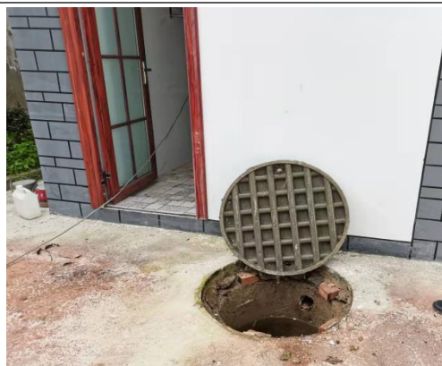
卫生间及化粪池
