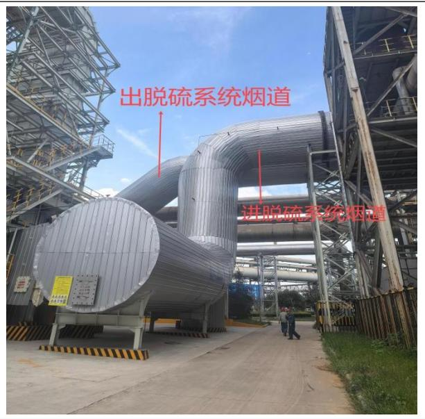
1#高炉热风炉脱硫系统
