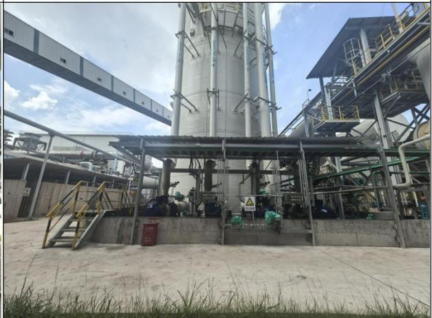
脱硫塔、泵站、围堰
